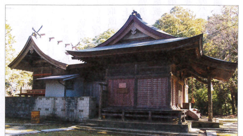
千葉県いすみ市 作田神社改修工事
