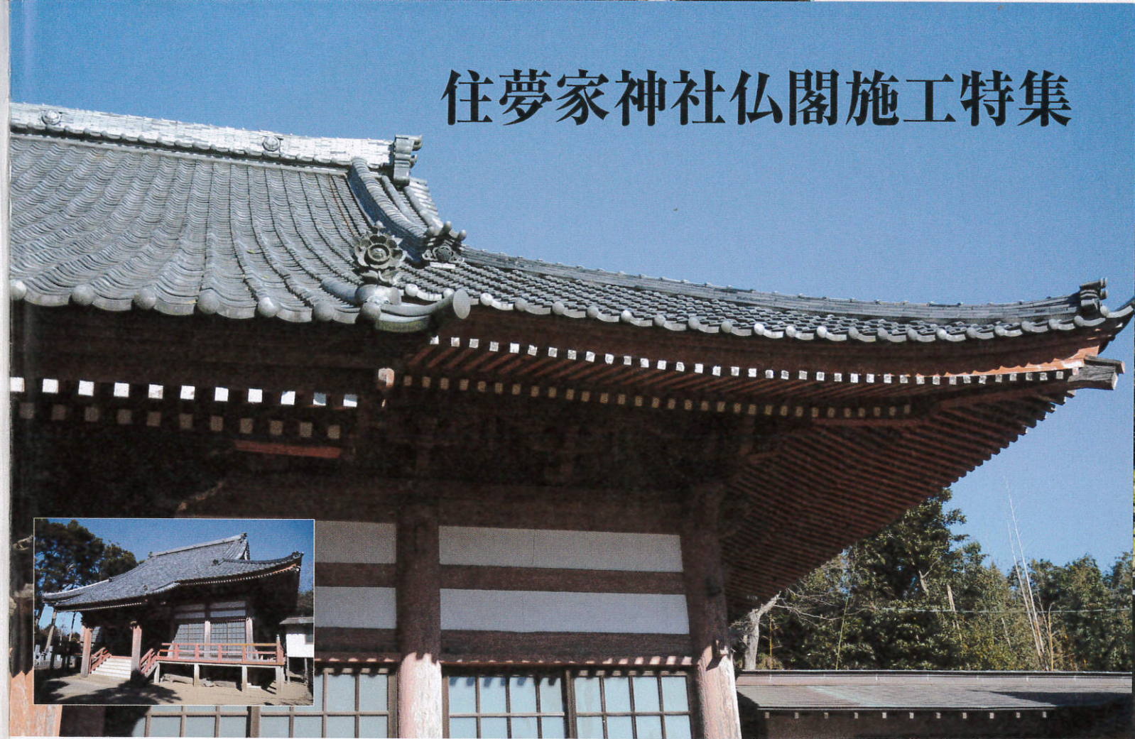
千葉県山武郡九十九里町真亀 浄泰寺 大改修工事
