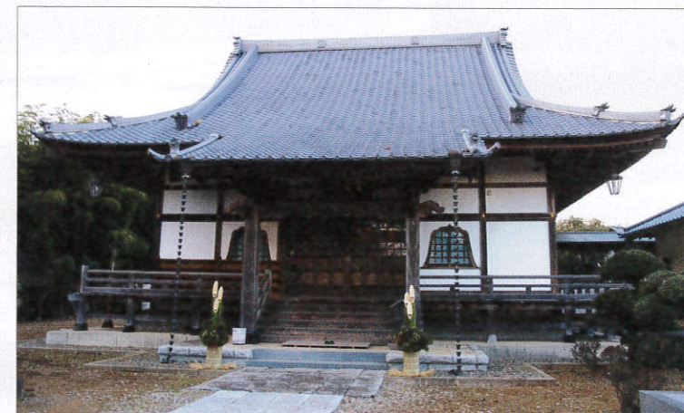
千葉県千葉市若葉区上泉町 實泉寺新築(保川建設(株))
