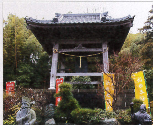
千葉県一宮町観明寺 鐘樓堂新築工事
