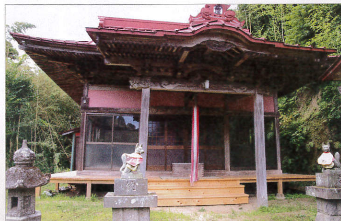
千葉県長生郡長柄町 山根稲荷神社改修工事
