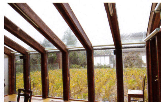
光触媒処理されたポリカーボネイト材を採用し雨が降るたびに屋根が掃除されます。
