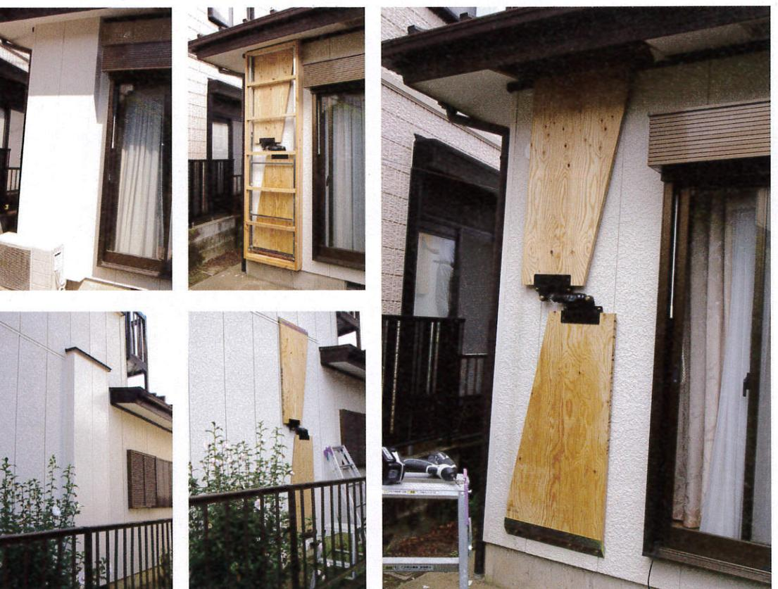
平成十九年七月に渡辺様邸に取り付けた減震装置です。既存の外壁の上にそのまま取り付けことが出来るので雨の進入の心配もなく簡単に取り付けることができます。この建物は耐震工事をしなくても地震には十分耐えられる建物でした、しかし渡辺様は地震に対する意識の高い方で地震予知に関する
